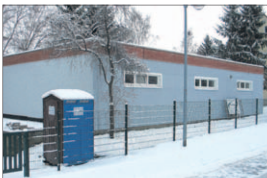
Die frühere Drogerie-Filiale in der Philipp-Müller-Straße in Wolgast wird zum „Gesundheitssportzentrum Formsache“ umgebaut. Foto: T. S.
